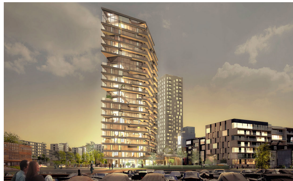
De woontoren 'HAUT' te Amsterdam, gebouwd op een constructie van hout
